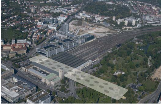
Gleisanlage mit skizzierten Tunnelverlauf: Aus dem Stuttgarter Kopfbahnhof wird ein um 90 Grad gedrehter und tiefer gelegter Durchgangsbahnhof (Foto: Oliver Braitmaier)
