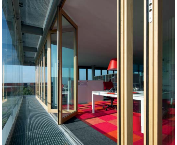
Beide Fassadenebenen lassen sich unabhängig voneinander variabel öffnen und vollständig auffalten
