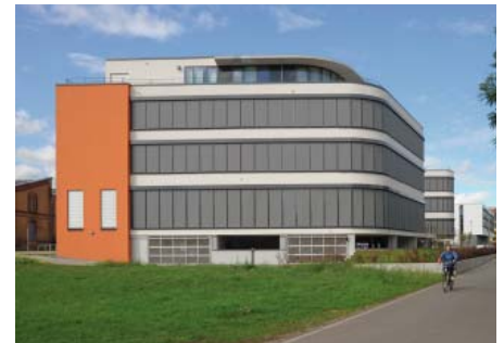
Bürogebäude „Elbe-Office“ (Foto: Birgit Uebe)
