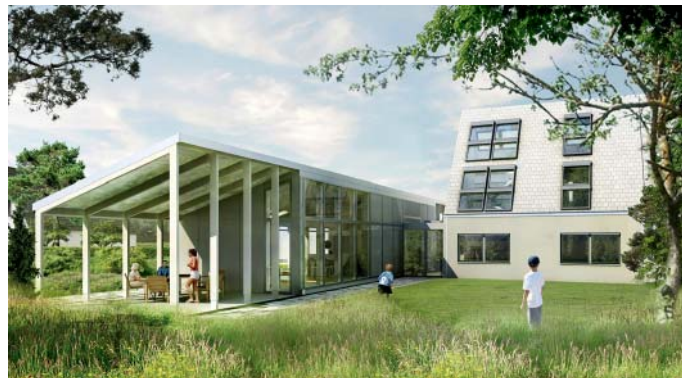
Statt Gemüse wird nun Energie angebaut: Die Photovoltaikmodule nutzen die gesamte Dachfläche des Erweiterungsbaus
