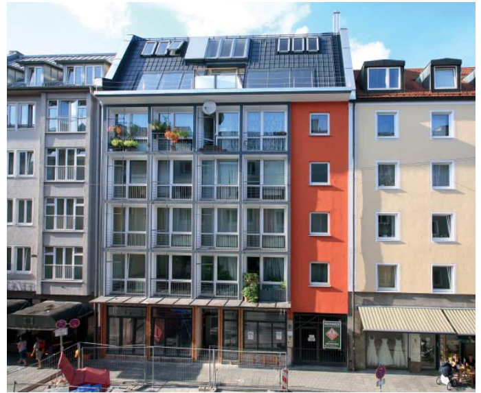
Energetisch saniertes Wohngebäude in der Landwehrstraße in München
