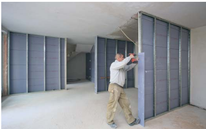
Neues Raumprogramm in Trockenbauweise
