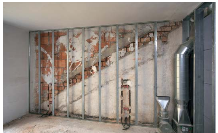
Wärmedämmung per Vorsatzschale W623
