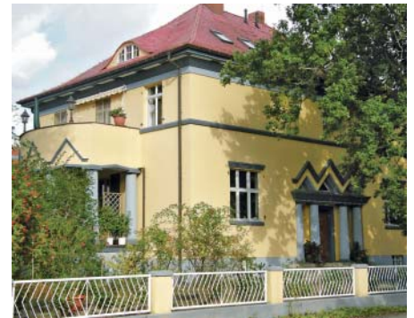
Für dieses denkmalgeschützte Wohngebäude in Güstrow konnte eine Heizkosteneinsparung von 33,4 % erzielt werden
