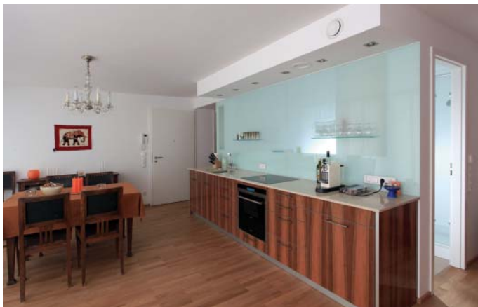
Abgehängte Decke mit Auslass für die Lüftungsleitungen
