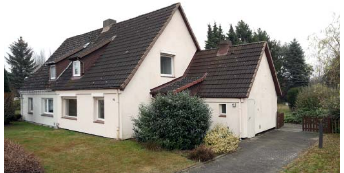
Das Siedlerhaus vor der Sanierung
