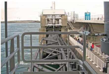
Steg entlang des Sturmflutwehrs
