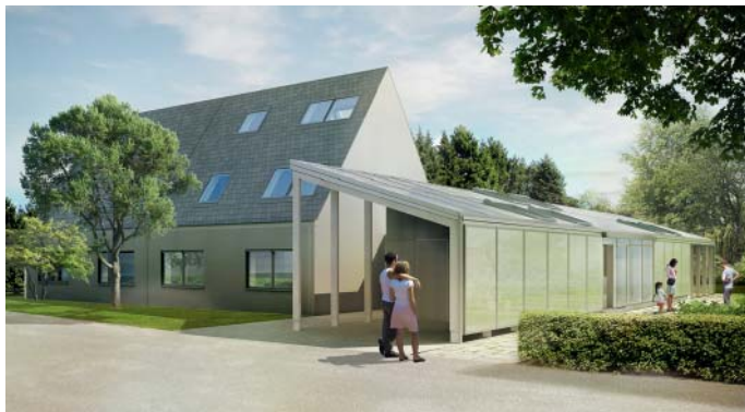
Die Fensterfläche wurde von ehemals 18 auf 60 m 2 erweitert
