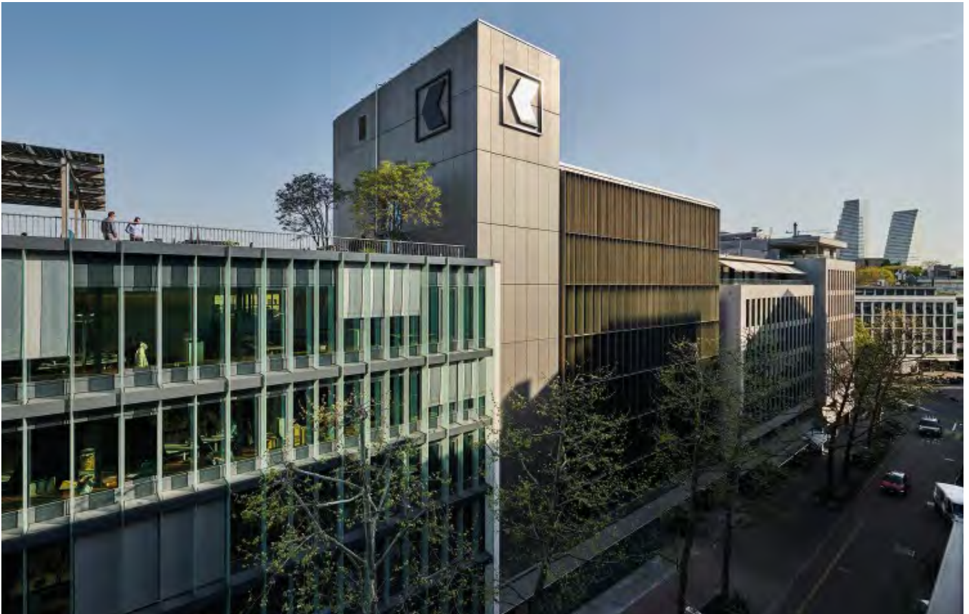
Hauptsitz der Basler Kantonalbank mit den Gebäuden Aeschenvorstadt (links) und Brunngässlein (rechts)
