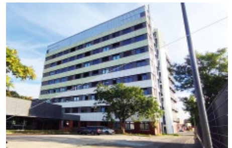
Fassade mit Algenbewuchs (Visualisierung: BAM)
