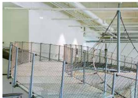
Eine begehbare Hängebrücke aus Stahl und Glas schwingt sich mit 27 m Spannweite durch die Ausstellung (Foto: Deutsches Museum)
