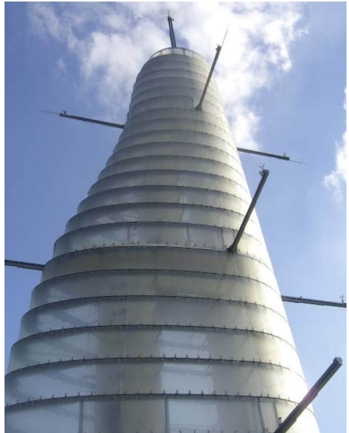
Die in alle 4 Himmelsrichtungen ausgerichteten Messausleger dienen den Probeentnahmen der Meteorologen
