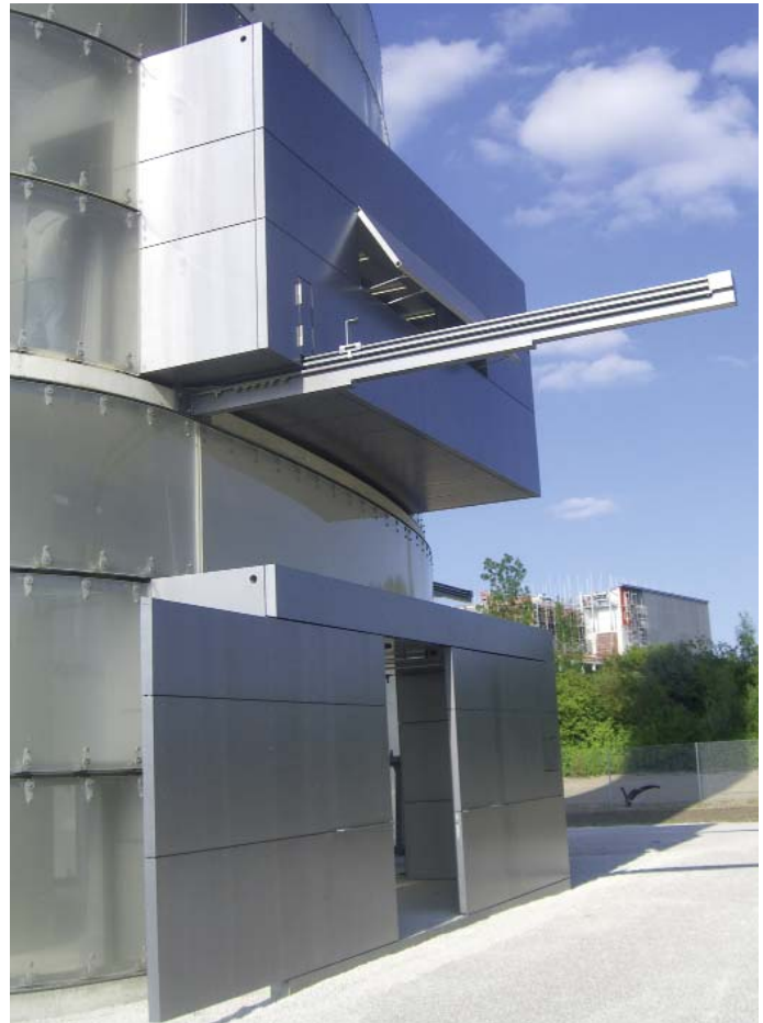
Die sog. Messbox und der Eingang bestehen aus Stahl und bilden einen bewussten Kontrast zur weich anmutenden Kunststofffassade
