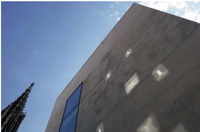
Glatte Oberfläche: Schalungsfugen und Ankerlöcher im Treppenhaus des Land- und Amtsgerichts in Frankfurt an der Oder
