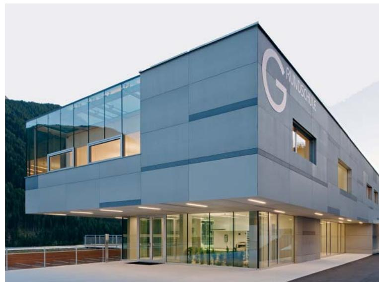
Grundschule St. Walburg in Italien: Die absolute Brandbeständigkeit und die hohe mechanische Festigkeit (fibrec ist form- und witterungsbeständig und somit hagelsicher) machen die Glasfaserbetonplatten interessant für den Einsatz an öffentlichen Gebäuden
