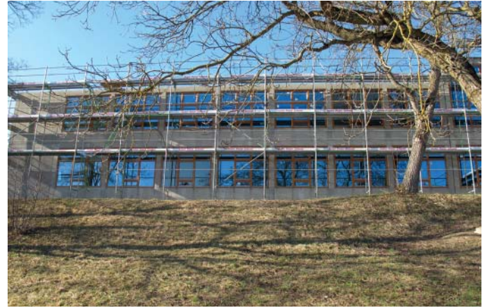
Einbau der neuen Fenster, 2011 (Foto: Ira Mazzoni)
