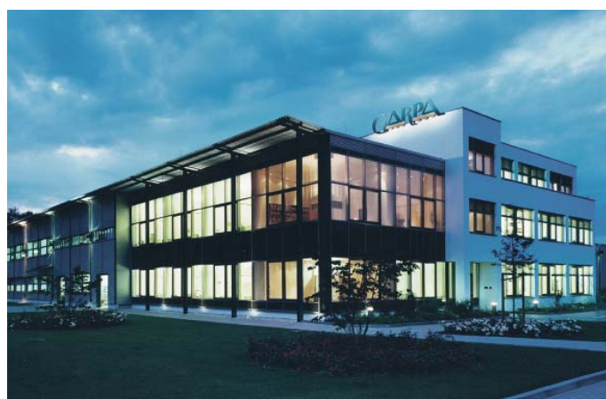
Neubau Logistikzentrum Garpa in Geesthacht bei Hamburg, Fertigstellung in Teilabschnitten 1997/2001 (Foto: Markus Tollhopf)
