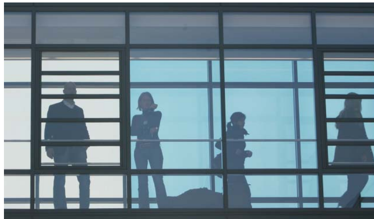
Die Südfassade des „Skywalk“ ist mit einer elektrochrom schaltbaren Verglasung versehen: Der g-Wert der Doppelverglasung kann von 38 % im hellen Zustand (links) auf 12 % im tiefblau eingefärbten Zustand (rechts) verringert werden (Foto: EControl-Glas)
