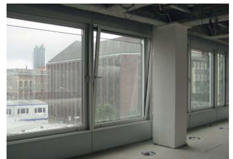
Zweischalige Fassade mit öffnenbaren Fenstern und außenseitig vorgehängter, fest stehender Verglasung, Mai 2011 (Foto: Kuballa)
