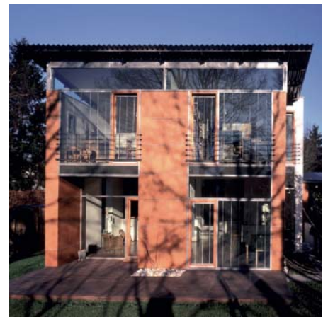
Neubau Einfamilienwohnhaus in Hamburg Nien- dorf, Fertigstellung 1996 (Foto: Markus Tollhopf)
