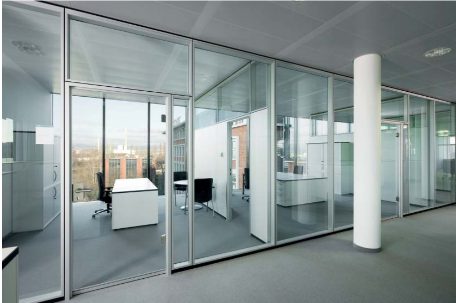
Alle Flurtrennwände bestehen aus doppelt verglasten Systemtrennwänden (Foto: Nikolay Kazakov)
