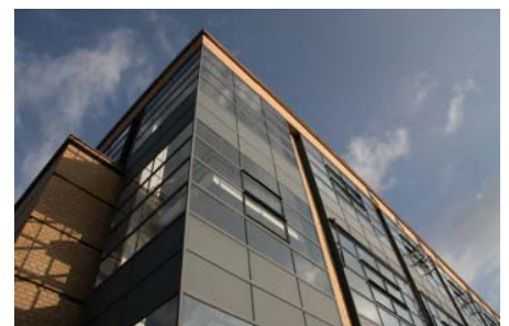
Über Eck geführte Curtain-Wall-Fassade mit innenliegenden Stützen (Foto: Fagus-GreCon)
