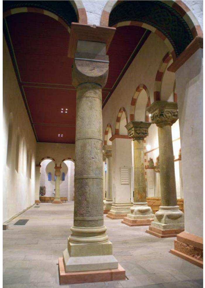
Nördliches Seitenschiff/Westliches Querhaus: Säule mit CFK-Bänderolensicherung
