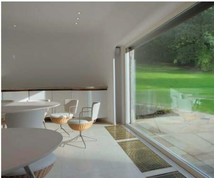
Die größtenteils elektrisch versenkbaren Fenster wurden durch wärmeisolierende Doppelglasscheiben ersetzt
