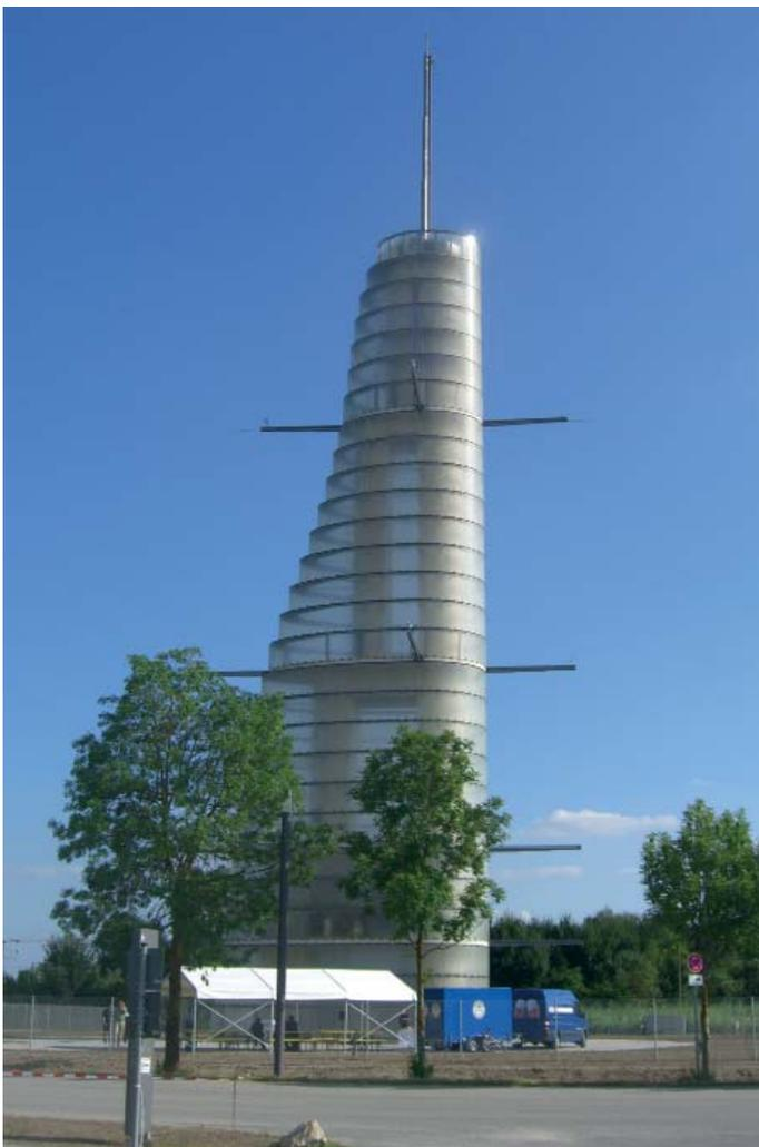
Dabei konnte durch die extreme Beweglichkeit der Konsolen und die hohe Verformbarkeit des 25 mm starken Kunststoffmaterials die 5-fache Sicherheit der gewählten Konstruktion für den maximalen Windsog erreicht und nachgewiesen werden.
