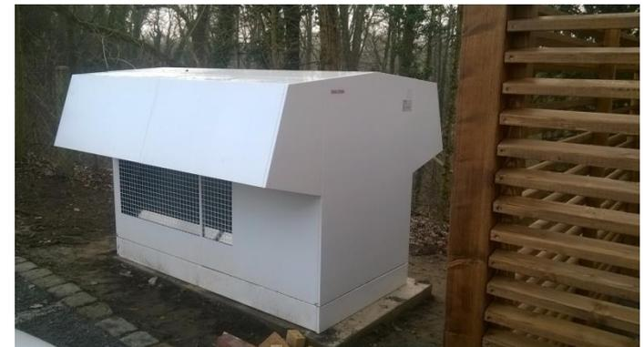
Wärmepumpen lassen sich unter bestimmten Bedingungen im denkmalgeschützten Bereich einsetzen.
